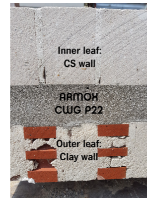
Fig.1-2: campioni di cavità murarie consolidate con ARMOX CWG P-22 per test a flessione
