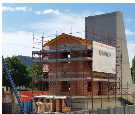
In alto: Esecuzione di test sismico all'Università di Brescia su edificio in muratura in scala reale senza intervento di consolidamento (test di riferimento)
