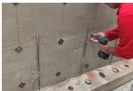
Foto 2: Applicazione dei connettori annegati nello spessore dell'intonaco
