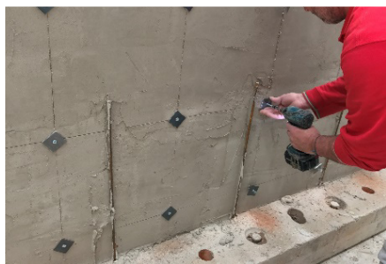
Foto 2: Applicazione dei connettori annegati nello spessore dell'intonaco
