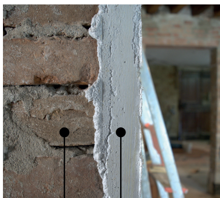
DRYNEX spessore 2,0 cm muratura storica in laterizio (XIV sec.)
